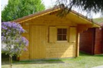
Vordach an Giebelseite
