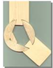
Eckverbindung Erker-Blockhaus
