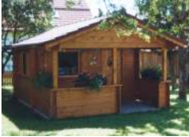
Balkonbrüstung und Vordach
